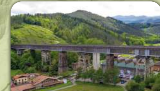
1 Ormaiztegi trenbidea Viaducto de Ormaiztegi
